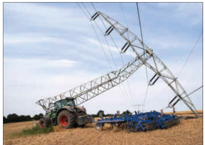
Traktor fährt in 110-kV-Freileitungsmast.
