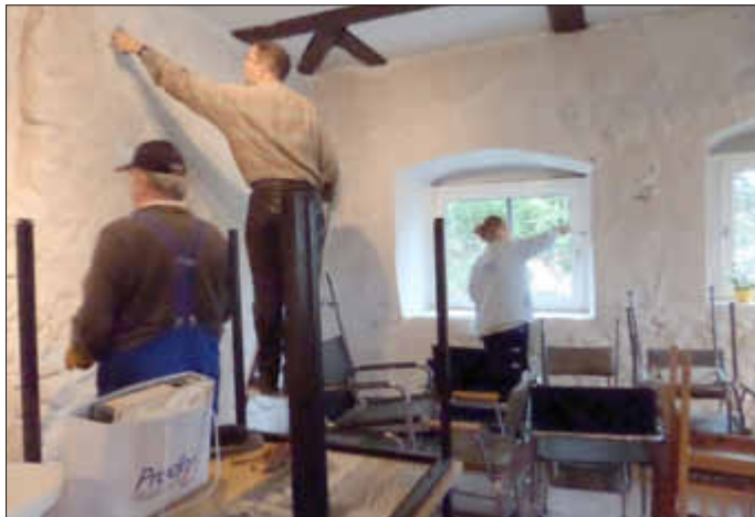
Helfer bei Innenarbeiten
