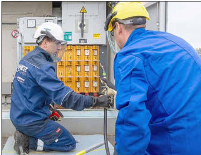
*Servicemonteur Christian Thrun (l.) schließt das Notstromaggregat an die in Betrieb befindliche Transformatorstation der WEMAG Netz GmbH an. Thoralf Taft vom THW assistiert ihm dabei.*
